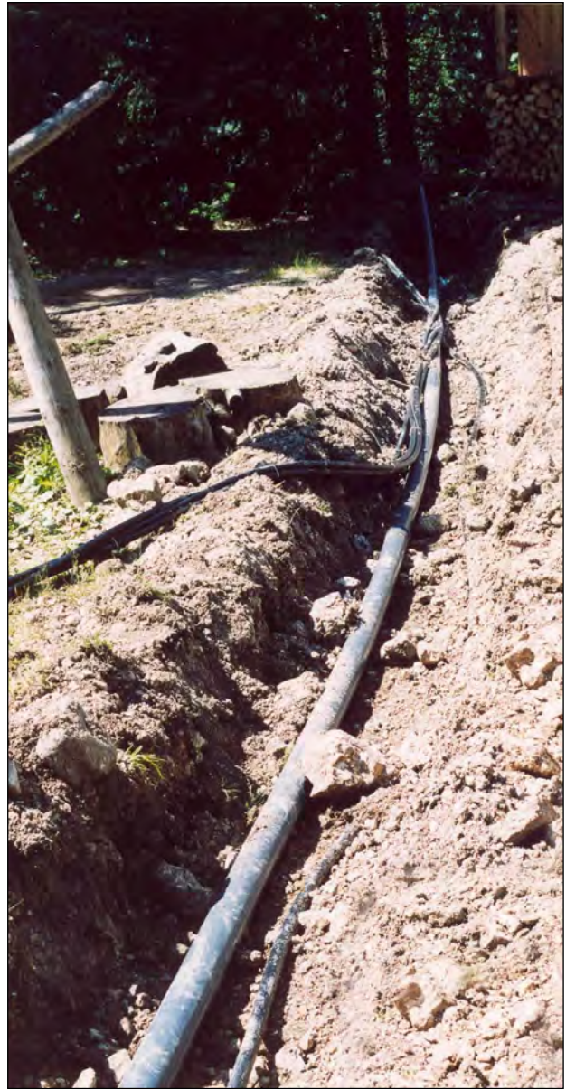
Anschlüsse für Station, Haus und späterer Abwasserpumpstation.
