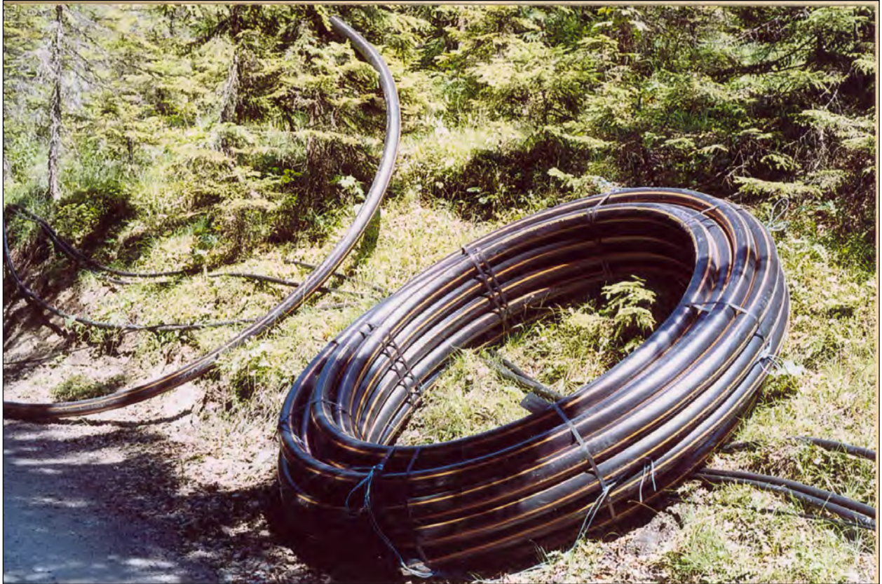
Das Abwasserrohr PE 100 90 x 8,2 mm
