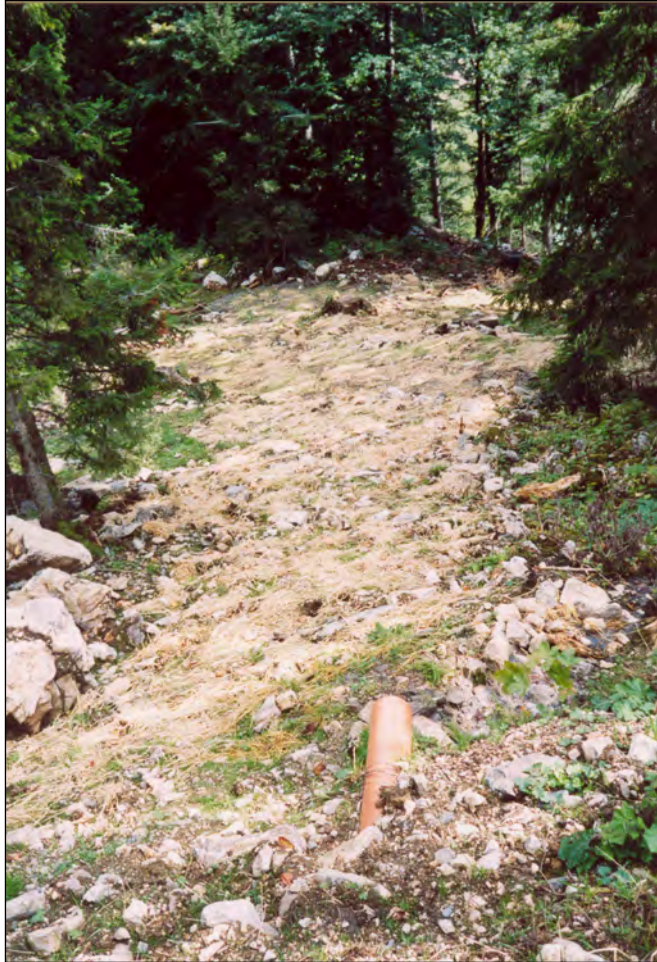
Graben sauber geschlossen. Abflussrohr der Kläranlage.
