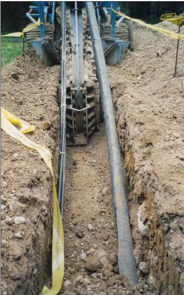
Alles fertig zum Zufüllen
