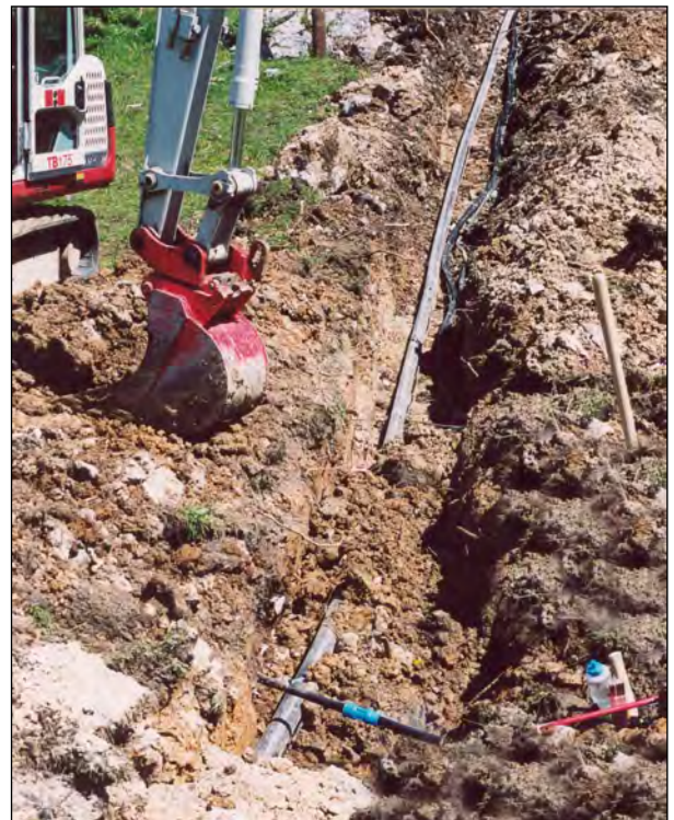
Die Wasserleitung mußte Vorübergehend durchschnitten werden.
