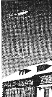
Die Wärmepumpe wurde mit dem Hubschrauber zur Hütte geflogen.
