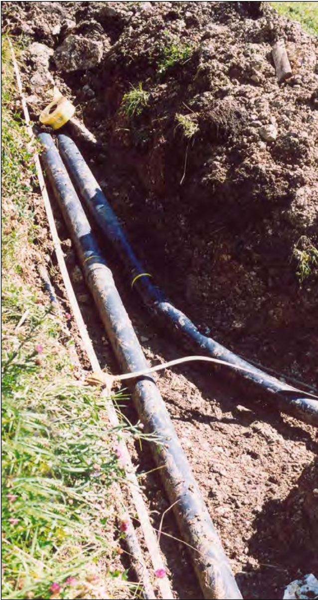
Hier soll die Station Brünstein stehen.
