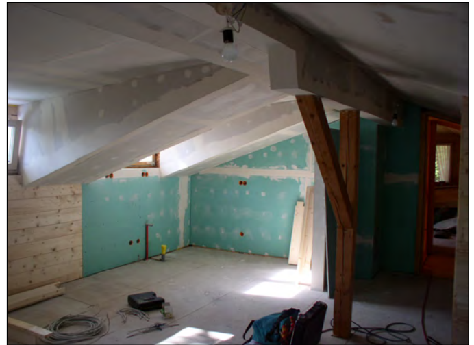
Der Innenausbau mit Rigips an den Wänden und Hamberger Parkett am Boden
