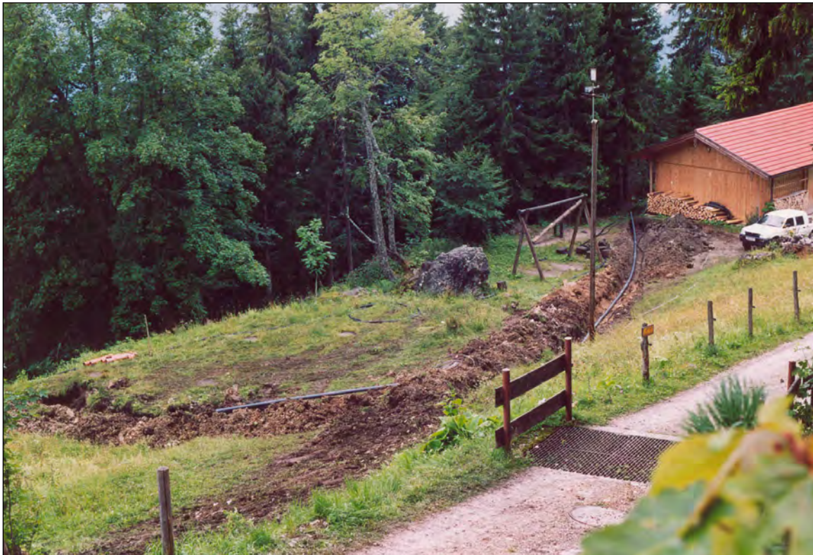
Graben sauber geschlossen. Abflussrohr der Kläranlage.
