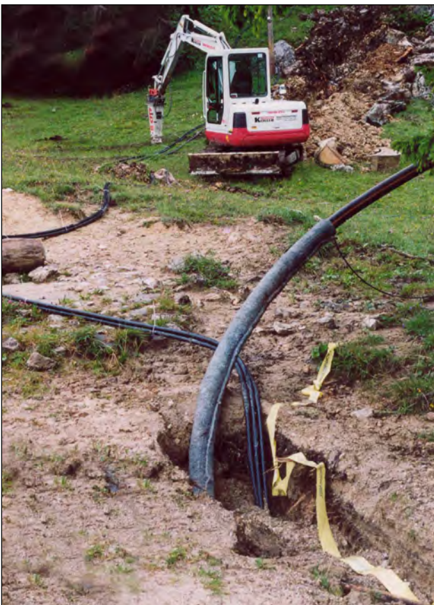
Anfang des Fräsgrabens.
