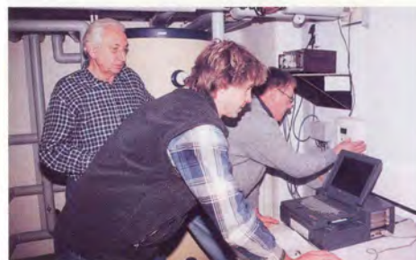
▲ Ein fest installierter Rechner und ein eigens von Josef (Sepp) Reisinger geschriebenes Programm steuert und überprüft permanent die Wärmepumpen-Anlage. Hier beim Datenabgleich: (v.l.): Gerd Badstübner, Josef Reisinger und Johann Naßl
