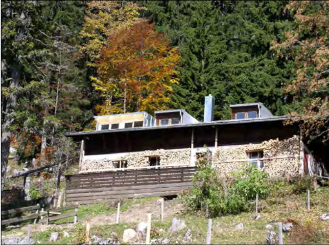
Im Dachgeschoß der Brunnsteingarage / Werkstatt wurde im Jahre 2002 ein Selbstversorgerraum für die Jugend der Sektion und Familien mit Kinder errichtet. Eine Dachgaube gibt den Blick nach Süden frei
