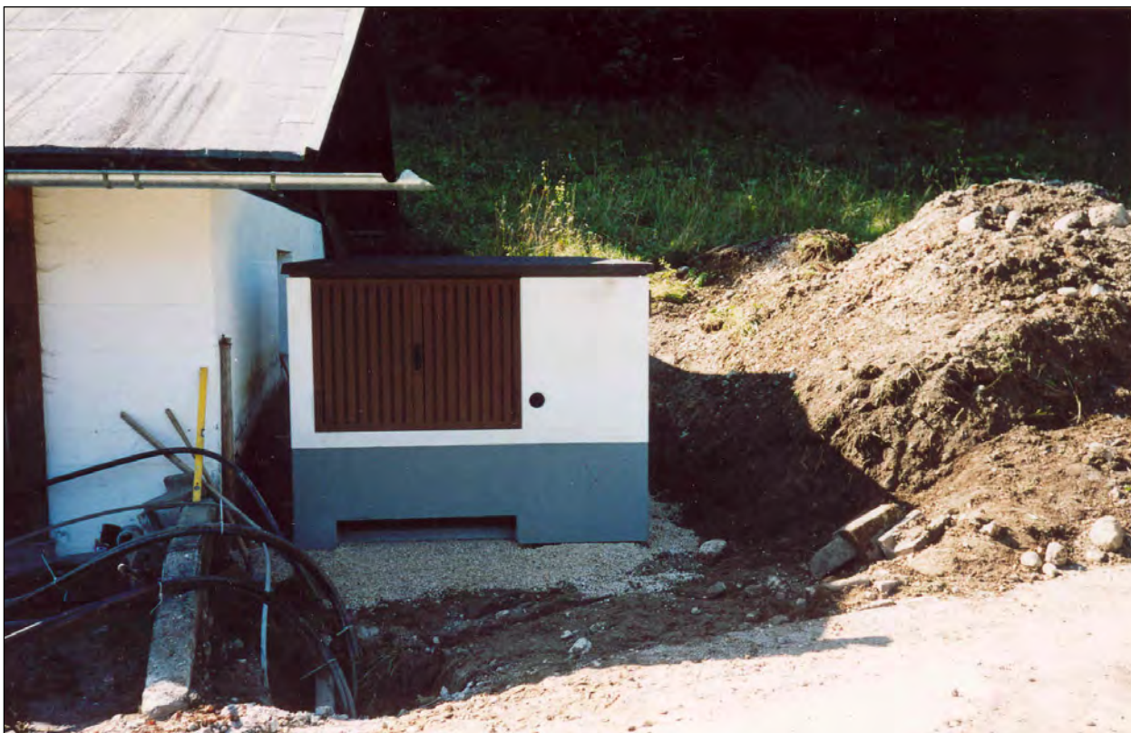
Die neue 20 kV-Kabelstation Rechenau. Eigentum der Gemeinde Kiefersfelden. Anschlussstelle des DAV-Kabels zum Brünsteinhaus.
