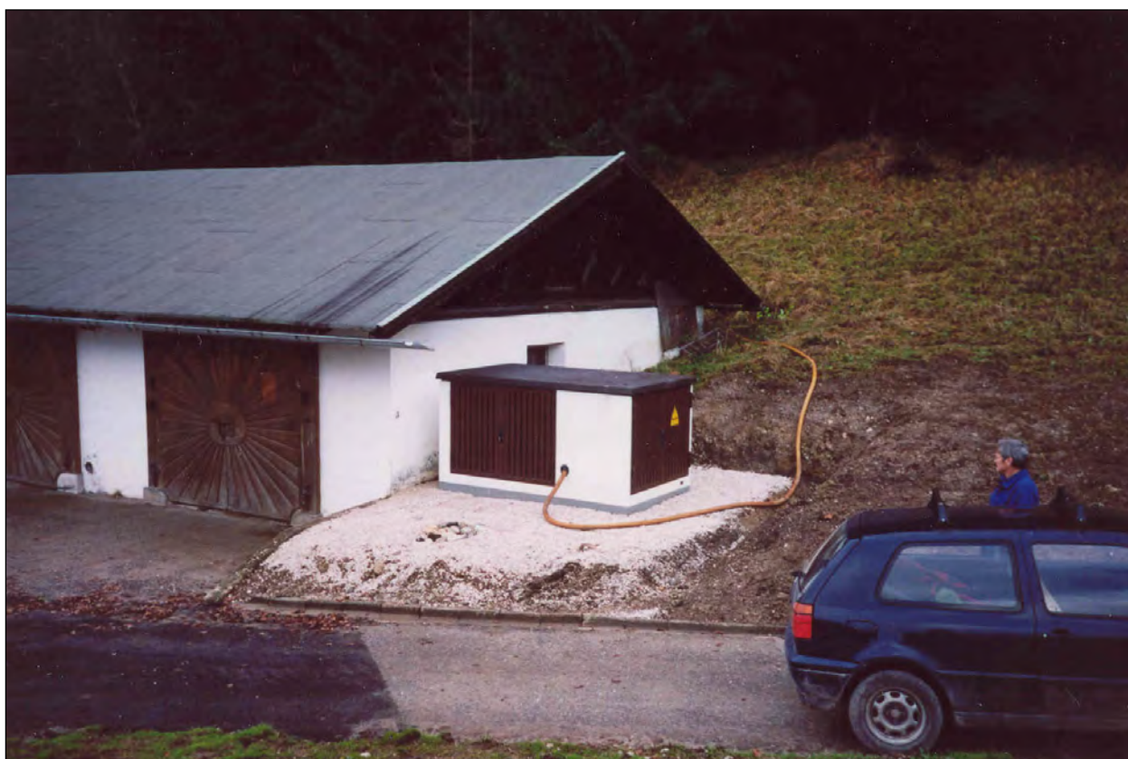
Die neue 20 kV-Kabelstation Rechenau. Eigentum der Gemeinde Kiefersfelden. Anschlussstelle des DAV-Kabels zum Brünsteinhaus.
